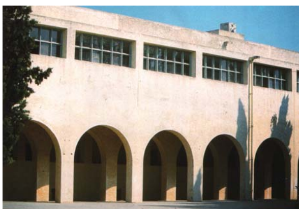
Fig.5 : Bâtiment administratif. Au nord galerie et couloir à l'étage protègent des rigueurs de l'hiver
